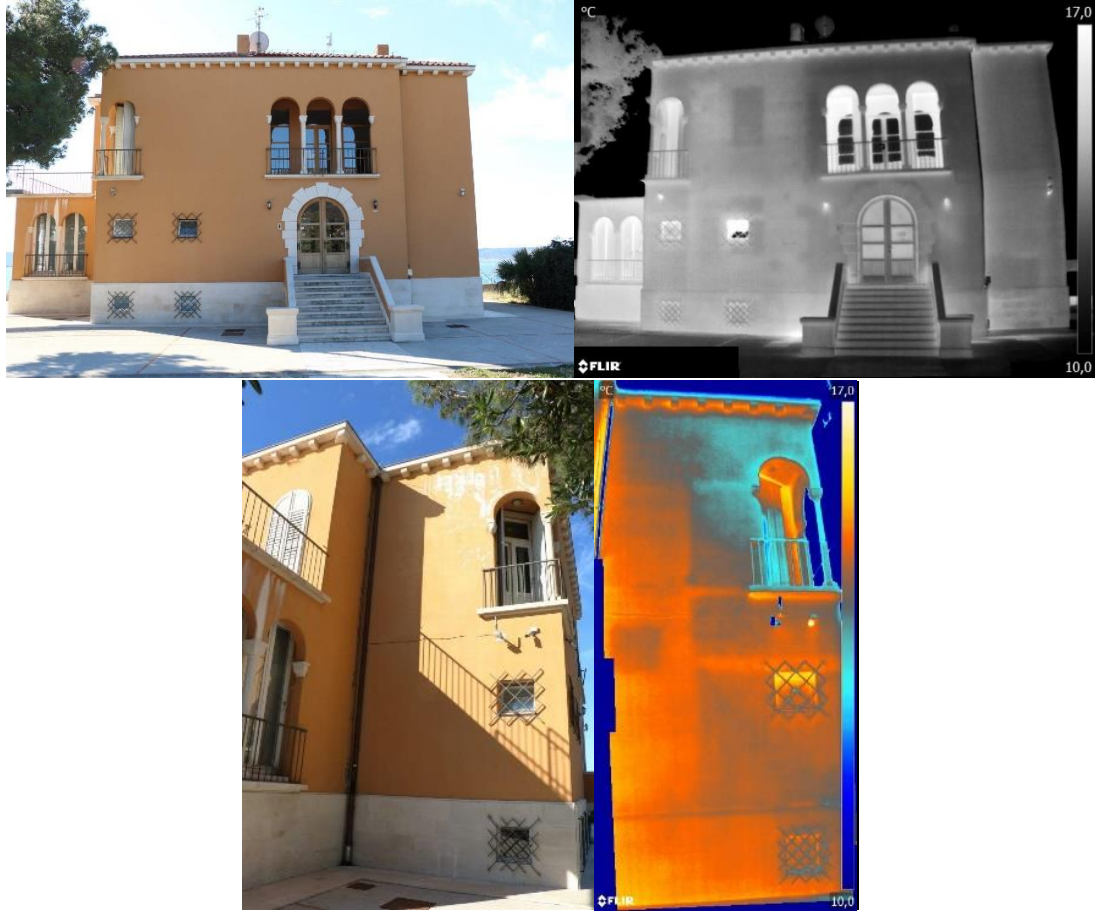
Slika 156 Različit sastav zida kao posljedica pregrađivanja i dogradnje
