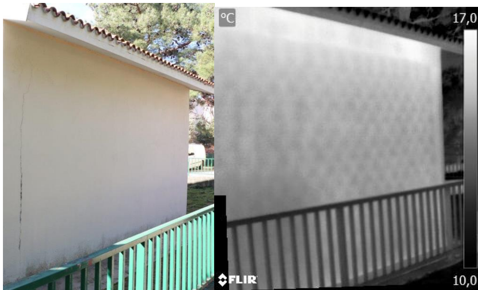
Slika 158 Zid od bloketa i betonski serklaži ruba krova i ugla zgrade
