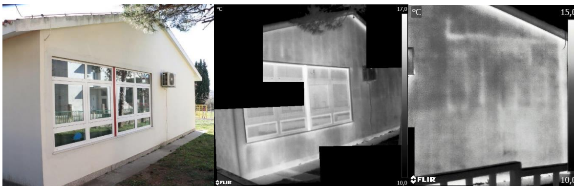
Slika 159 Montažne betonske ploče
